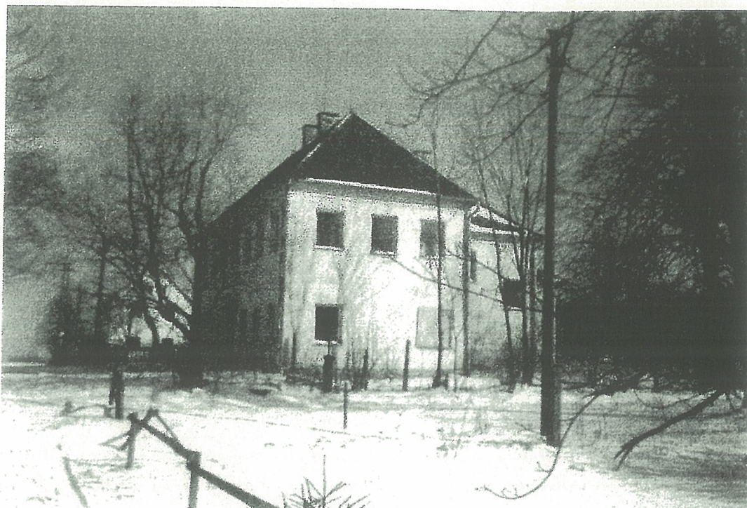
Bývalá škola v Albrechticích u Frýdlantu, v současné době chátrající objekt.
