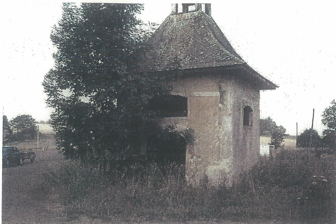
Kaplička před rekonstrukcí v roce 1999. Změna konstrukce střechy a poslední řádná oprava byla provedena v roce 1930.
