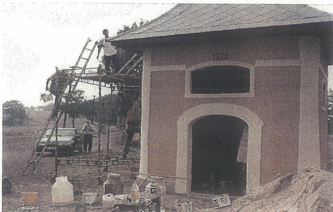
Kaplička v průběhu rekonstrukce firmou SCANDIC Consulting s.r.o. z Liberce, jako dar obci Albrechtice u Frýdlantu.
